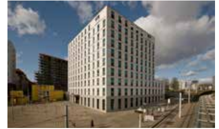
the niu Ridge, Riebeckplatz Halle (2019)
