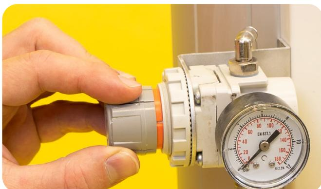
Entlüftungsventil am Druckminde-
