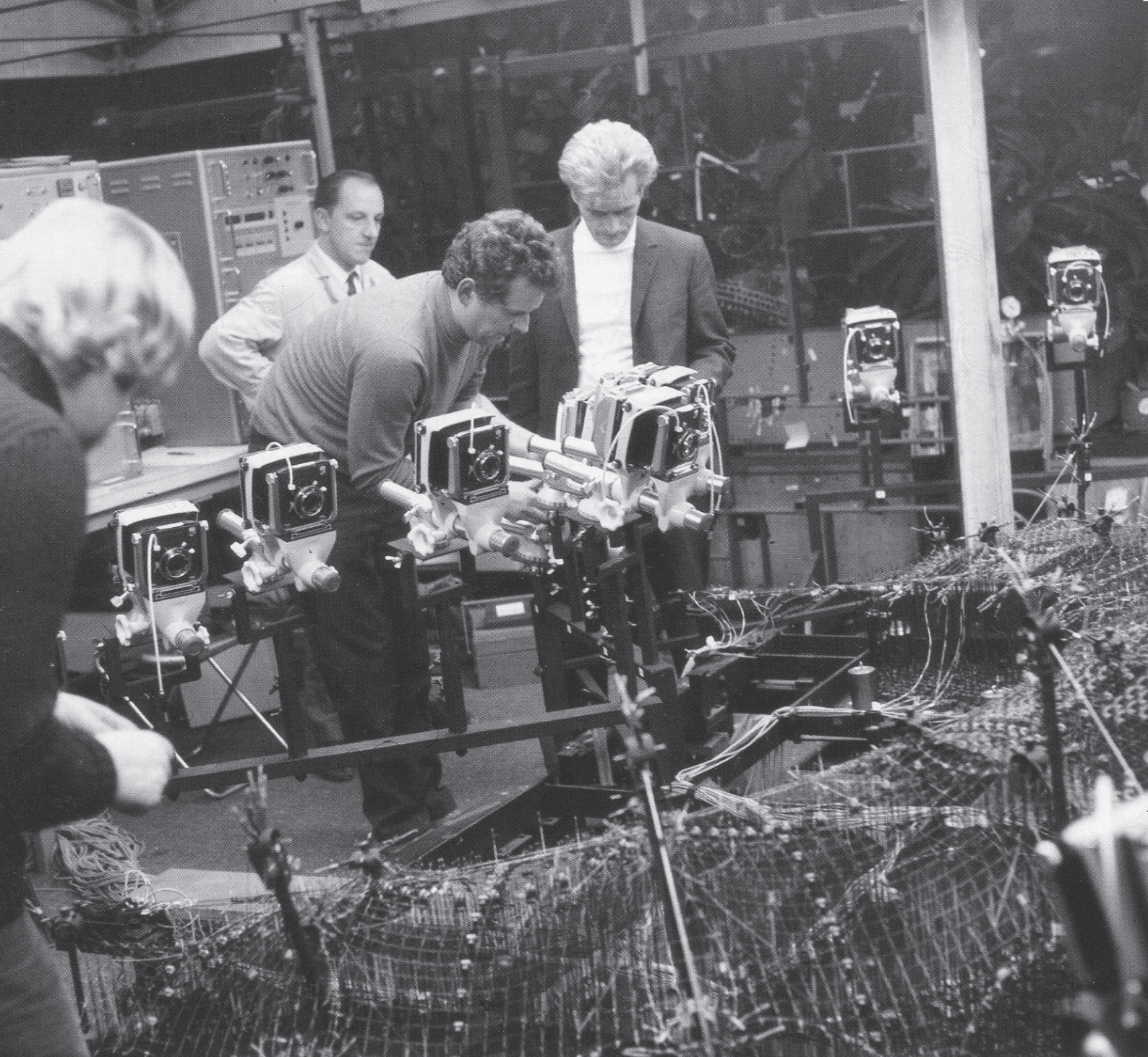
Abb. 12: Messmodelle für das Olympiادach in München 1972 (Anfänge der computerge- stützten Formfindung)
