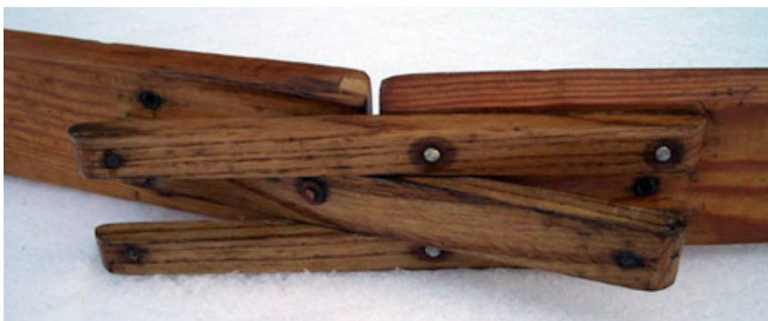
Bordwandverbindung
