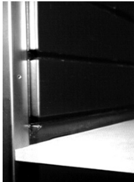
Detail der Schubladenführung aus tiefgezogenem Kunststoff
