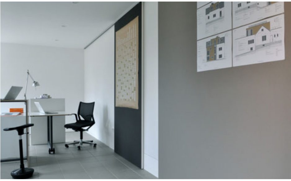
Tischlerplatte Lightwood 300, Stärke 28 mm, MDF Deck, weiss grundiert; Lack Weiss Seidenmatt; als Pinboard einseitig beplankt mit Forbo BulletinBoard, 6 mm
