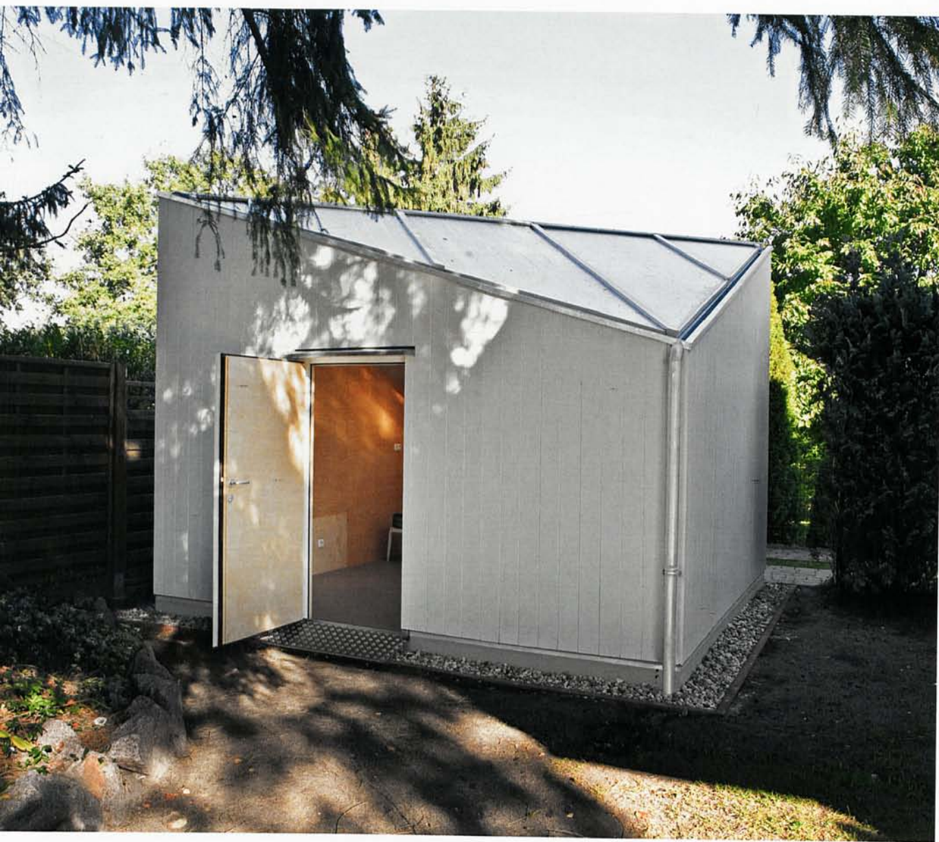
Oben: Das um 90° gedrehte Satteldach besitzt eine geschlossene und eine transparente Hälfte, letztere für die Belichtung der Pflanzen im Winterquartier.
