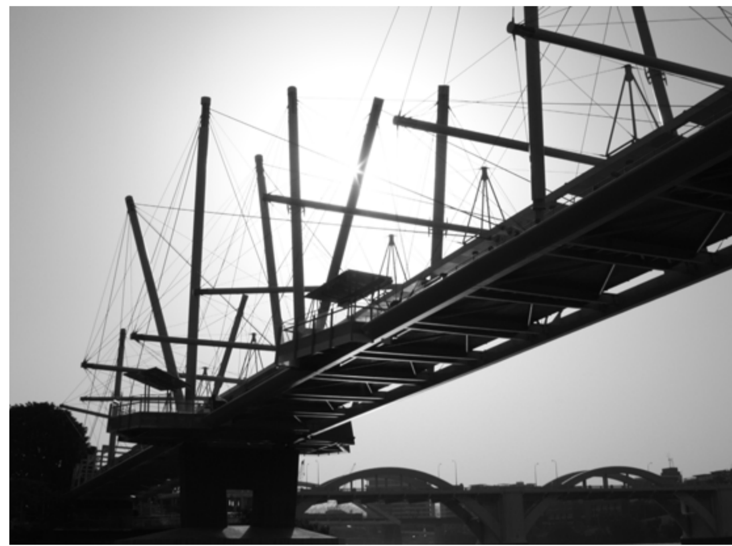
Die 2007 eröffnete Kurilpa Brücke in Brisbane (Australien) ist die bisher größte hybride Tensegrity Brücke der Welt
