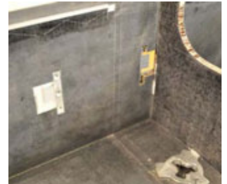
Takus Griffe arretieren sich durch Magneten und können einfach gelöst werden, wenn sie nicht benötigt werden.
