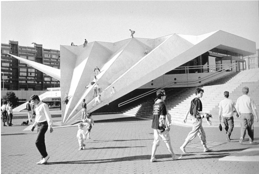
Abb. 3: Die begehbare Dachkonstruktion der Fußsummbauung des Fernsehturms in den 1970er Jahren
