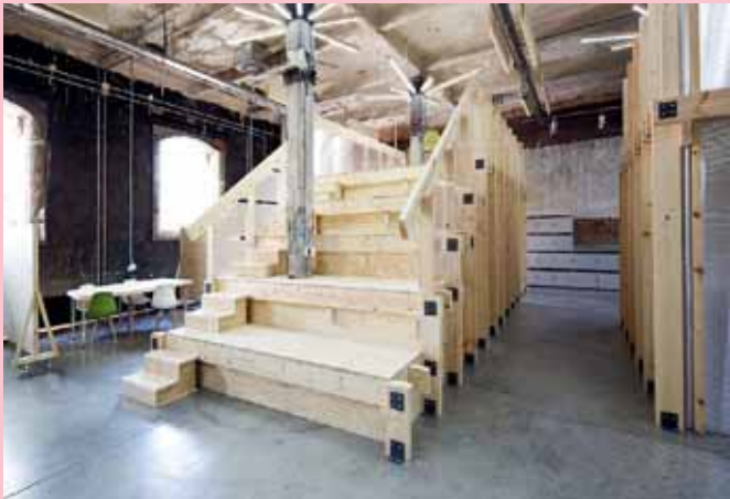
Eine einfache Konstruktion aus Kiefernholz strukturiert die Halle in Gruppen- und Einzelarbeitsbereiche. Fotos: © Simona Rota
