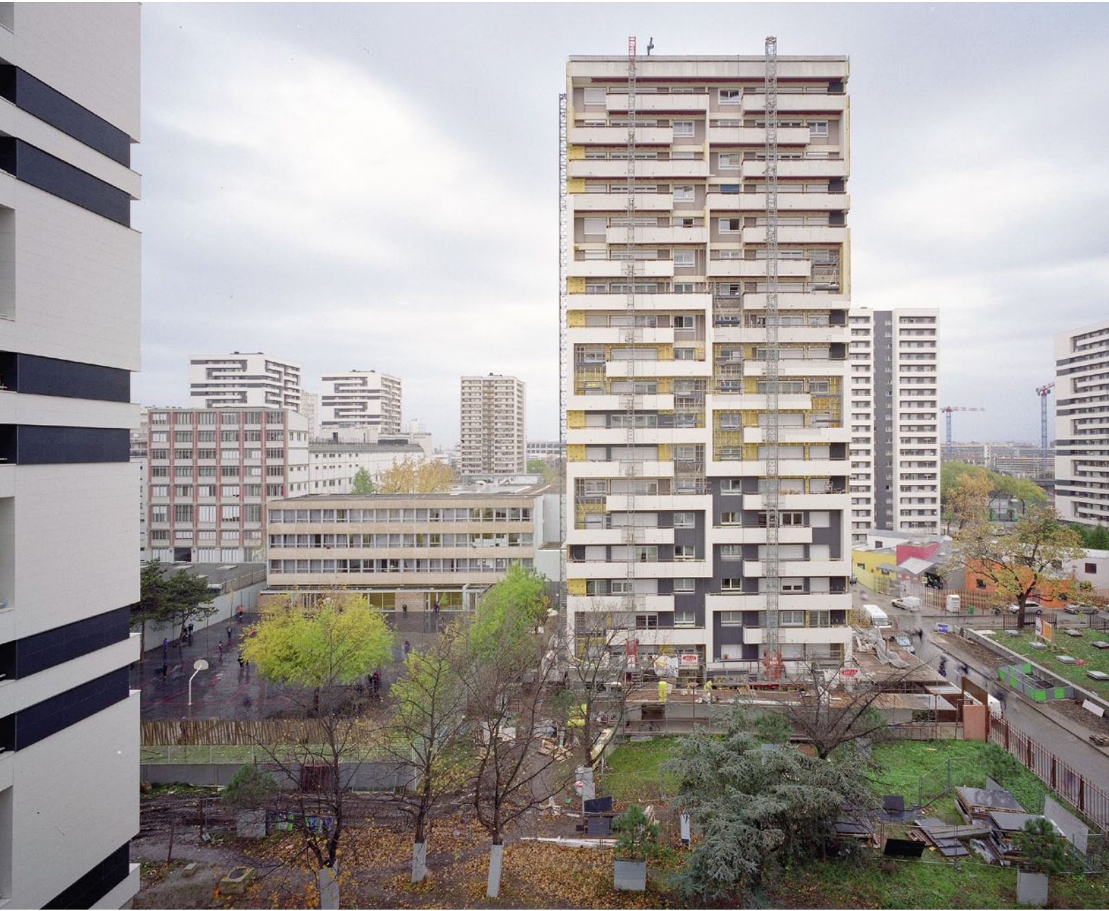
Groupe Arcane legte weiße und schwarze Platten auf eine 16 Zentimeter dicke Wandisolierung und stärkte so die alten Fassaden-konturen der Hochhäuser
