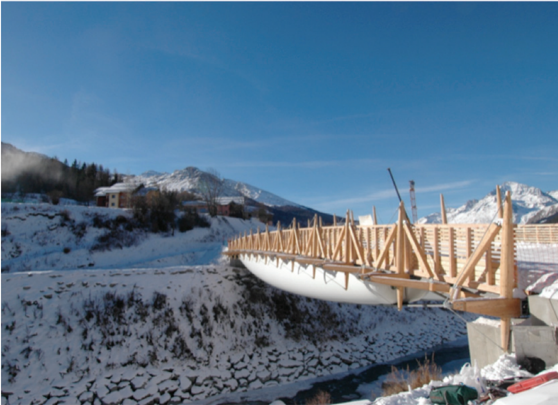
52 Meter Spannweite: Diese Skiläufer-Brücke in den französischen Alpen nutzt die pneumatische Tragstruktur Tensairity. Mit Luft gefüllte PVC-beschichtete Gewebe spielen dabei eine wichtige Rolle.
