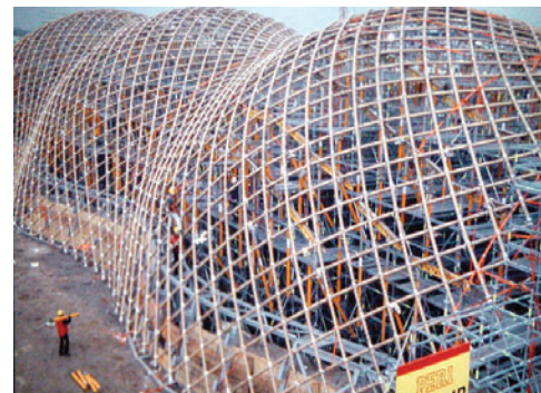
Japanischer Pavilion im Bau von Shigeru Ban Expo 2000 in Hannover
