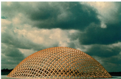
Gitterschale auf der DEUBAU, ESSEN 1962, Frei Otto
