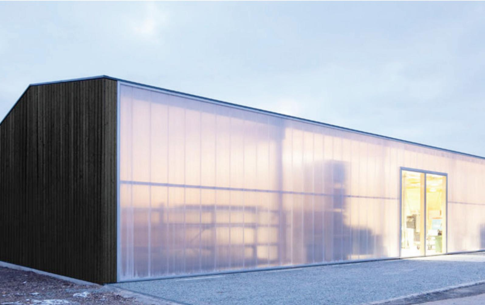
Der Funktion einer Werkhalle entsprechend ergibt sich eine klare Grundform des Baukörpers. Von drei Seiten ist die Schreinerei mit einer Holzfassade verkleidet, an der Nordfassade fällt Tageslicht blendfrei gestreut durch die Polycarbonat Stegplatten wie bei einem Atelier in die Werkhalle.
