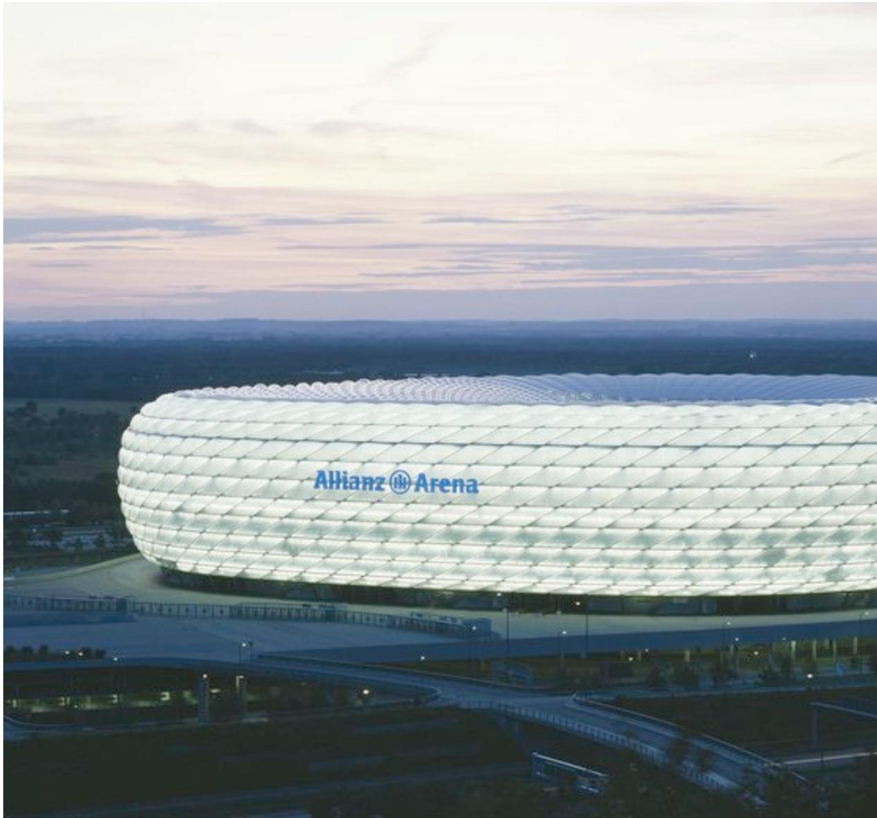
Die Fassade der Allianz Arena besteht aus selbstreinigenden ETFE-Folienkissen, die von innen beleuchtet werden können. 2760 rautenförmige Kissen aus transparenten ETFE-Folien bilden 66.500m<sup>2</sup> Bedachung und Fassade. Ventilatoren blasen die Kissen mit einem dauerhaften Druck von 350 Pascal auf. Jedes dieser speziellen Hydraulikkissen trägt eine Maximallast von 8t und hält einem Windsog von 22t stand.
