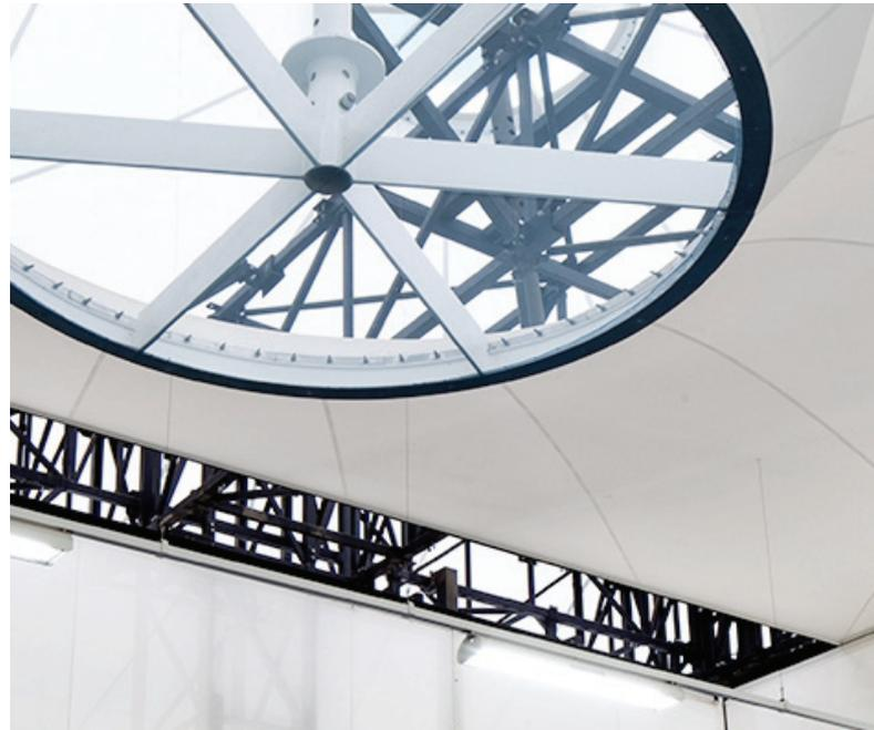
Nach der Veranstaltung werden Membranen, Spannringe und Anschlüsse für den Transport flach verpackt und an einen anderen Veranstaltungsort gebracht. Es ist geplant, zwei der drei mobilen Gebäude in Glasgow für die 2014 Commonwealth Games einzusetzen. Die Standard-Fachwerkträger werden nach dem endgültigen Rückbau an die Baufirma zurückgegeben.
