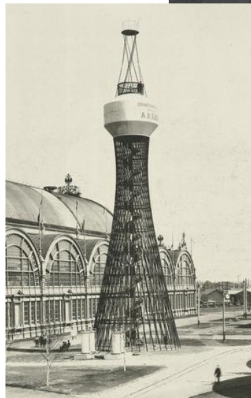
Das weltweit erste Bauwerk in Hyperboloidkonstruktion, 1896
