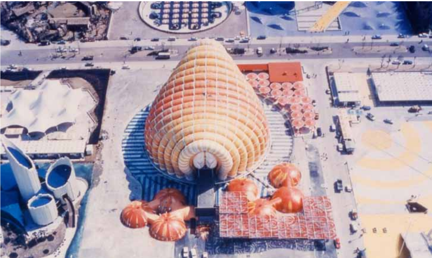
Abb. 37 Der Fuji Pavillion, Yutaka Murata, Expo 1970 in Osaka Der Pavillon der Fuji-Gruppe war die größte luftgefüllte Struktur der Welt. Die Struktur besteht aus 16 gleich langen Bögen.
