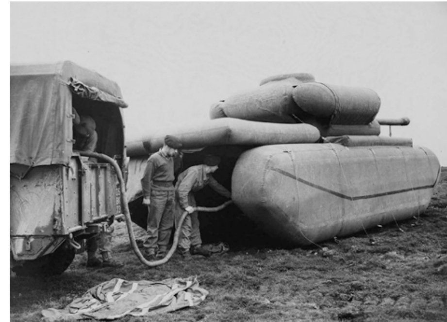
Abb. 16 Britische Truppen blasen einen Gummi-Dummy-Tank auf. 1940.
