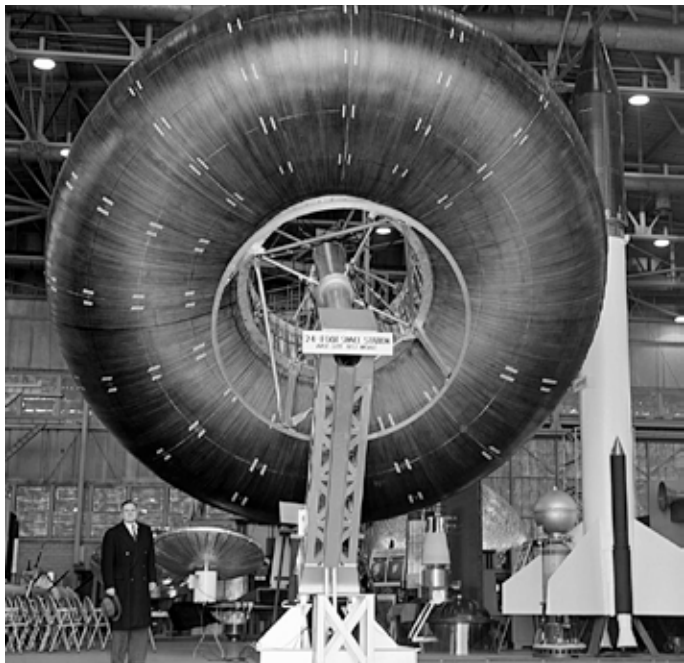
Abb. 27 Der aufblasbare Habitat-Prototyp der NASA entstand 1961 im Kontext der Pläne einer internationalen Raumstation.
