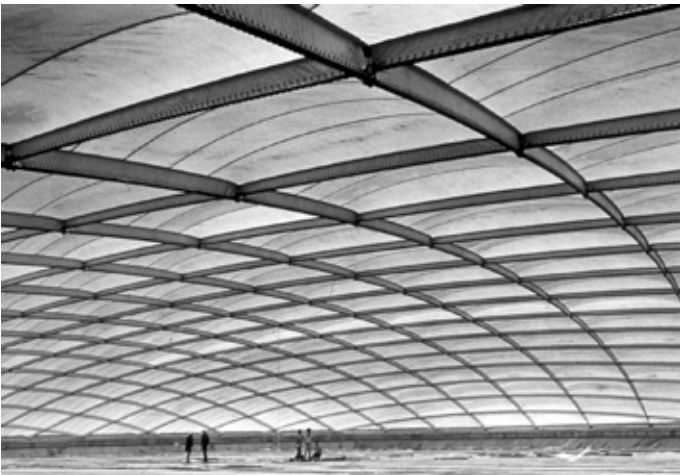
Dieses pneumatische Gebilde stellt den vorläufigen Höhepunkt in der Geschichte des Bauens mit Luft. Ein Oval von 142 m Länge und 83 m Breite wurde mit einer luftgestützten Membran überzogen. Ein Netz aus diagonal gespannten Seilen sicherte das steppenartig strukturierte Dach. Die flache Wölbung bot dem Wind wenig Angriffsfläche.
