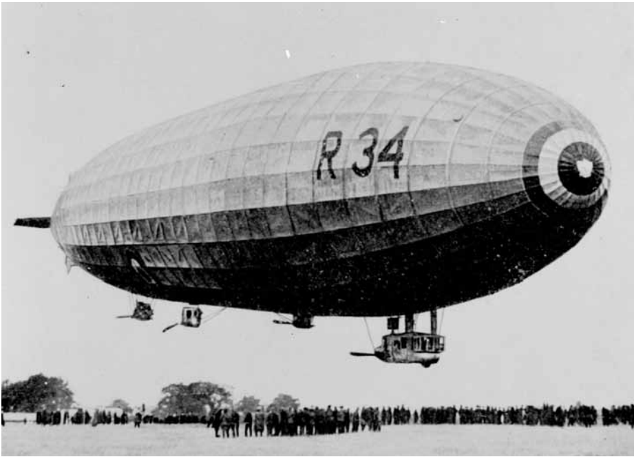
Abb. 08 Das englische Luftschiff „R34“ war mit 196 Metern mehr als doppelt so lang wie ein heutiger Airbus A380 und überquerte 1919 als erstes Luftschiff den Atlantik.
