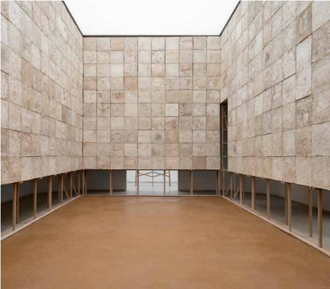
Mit Myzel-Panelen ausgekleideter Innenraum des belgischen Pavillion, Architekturbieniale 2023
