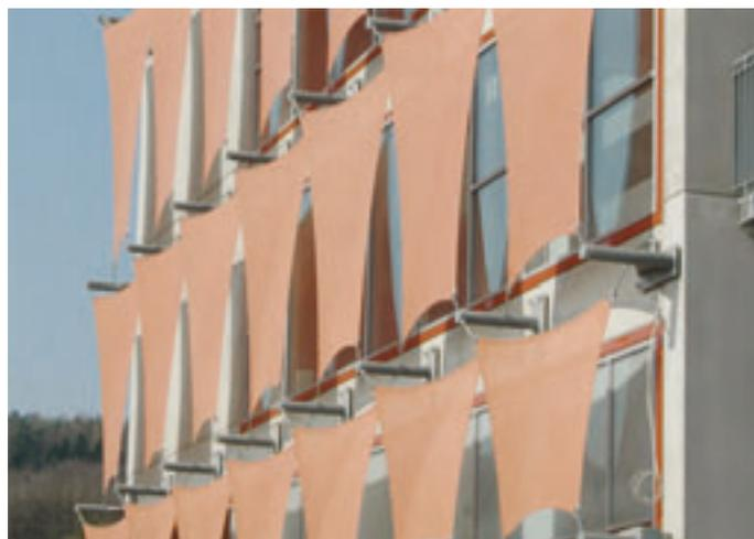
Membran als Fassadenverkleidung schützt das Gebäude vor Wind und UV-Strahlung
